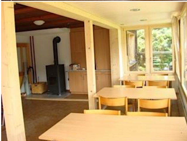
Im Aufenthaltsraum steht der neue wasserführende Kaminofen, welcher zusammen mit den Sonnenkollektoren auf dem Dach für die Wärme im Haus sorgen soll.
