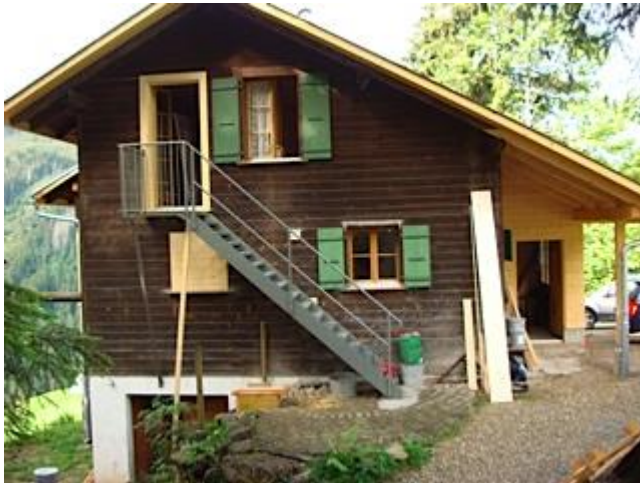
Auf der Rückseite des Hauses wird die Fluchttreppe erstellt.
